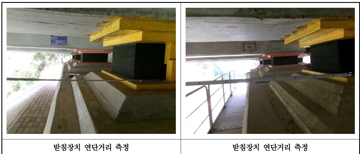
【사진 35.3.15】 교량받침장치 연단거리측정
