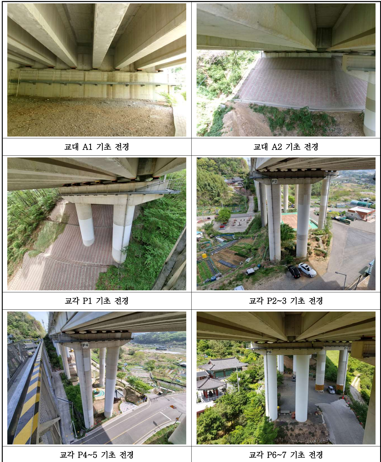
【사진 35.3.12】 기초 전경
