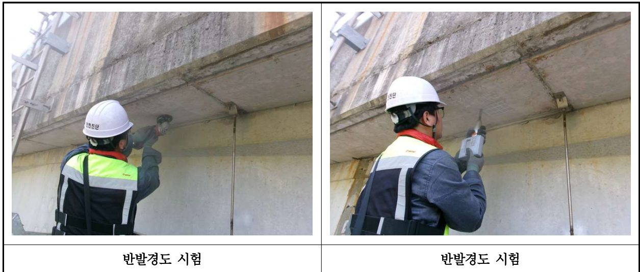
【사진 35.4.2】 반발경도시험 현장사진
