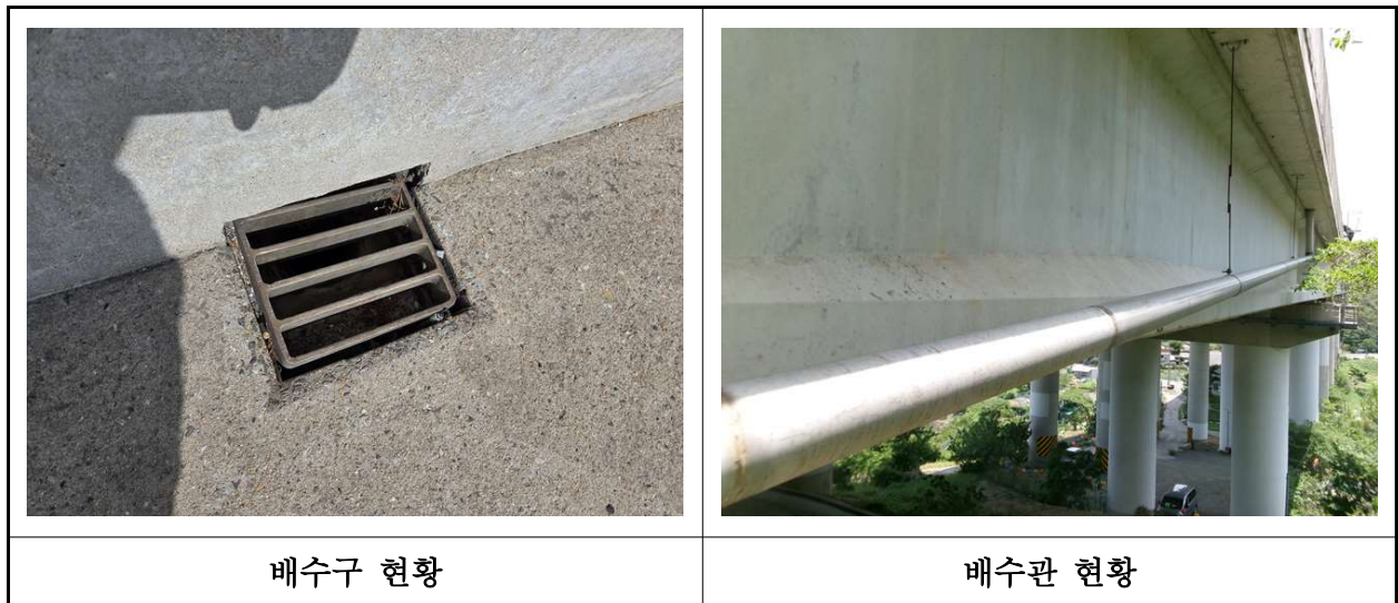
【사진 35.3.22】 배수시설 전경
