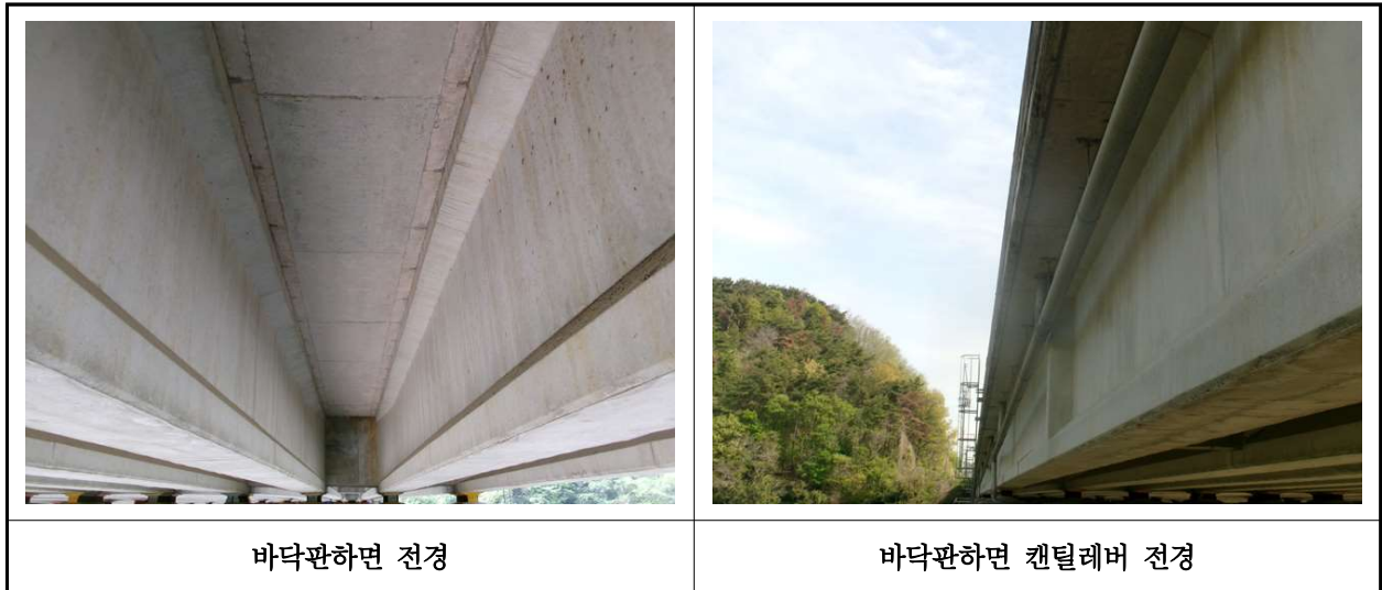
【사진 35.3.2】 바닥판하면 전경
