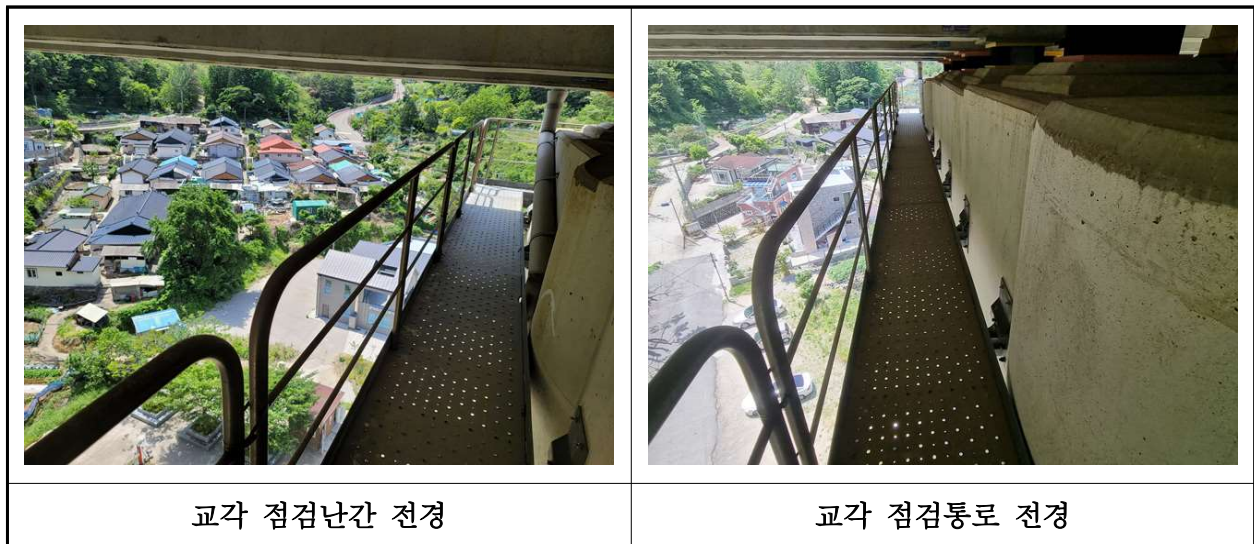
【사진 35.3.26】 교량 점검시설 전경
