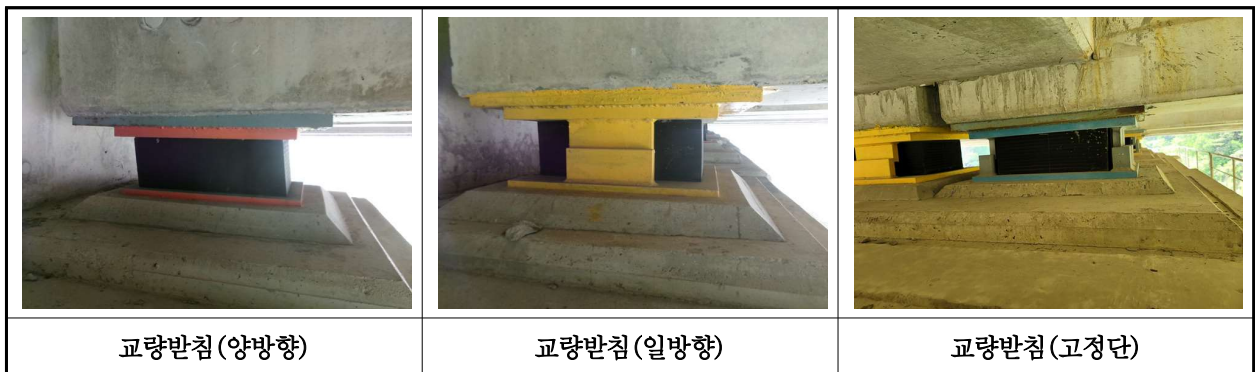
【사진 35.3.13】 교량받침 전경
