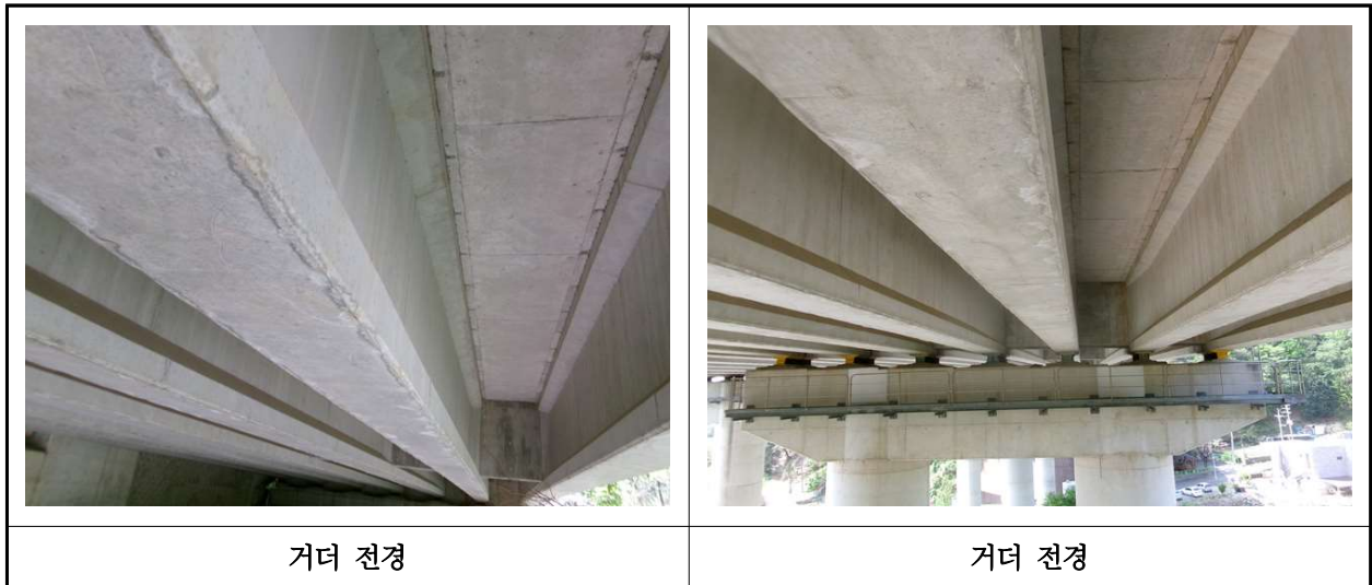
【사진 35.3.4】 거더 전경
